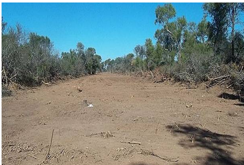
Figura 9: Apertura de picadas y armado de cordones en desmonte mecánico.
